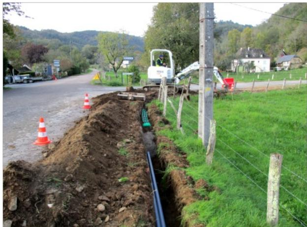
L'entreprise CONNEXION AU MONDE (CAUM) dont le siège est dans les Pyrénées Atlantique et qui dispose d'une antenne à St Pantaléon de Larche, a débuté sa mission. Mission qui consiste à poser les câbles (fibre optique), à réaliser des raccordements et à installer les coffrets Point de Branchement Optique (PBO). Dans la foulée, un Sous Répartiteur Optique (SRO) sera installé au bourg de Monceaux.
